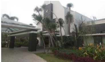
Gambar 4.8 Kantor Pemasaran Citra Raya
